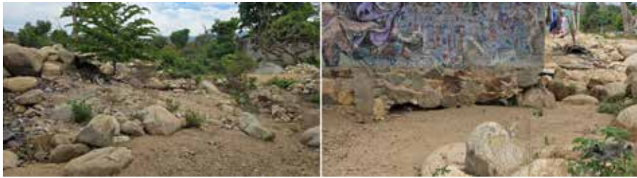
Figura 2. Roca ígnea expuesta bajo vivienda en ladera. La acumulación pétrea que sostiene la cimentación forma parte de los arrastres históricos de la microcuenca, evidenciando la continuidad material entre soporte y potencial movilización.
