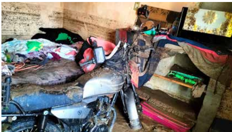
Figura 3. Acumulación sedimentaria en interior de vivienda. La redistribución material atraviesa el espacio doméstico, inscribiéndose en muros, objetos y superficies, y evidenciando la continuidad entre pendiente, cauce y habitación.
